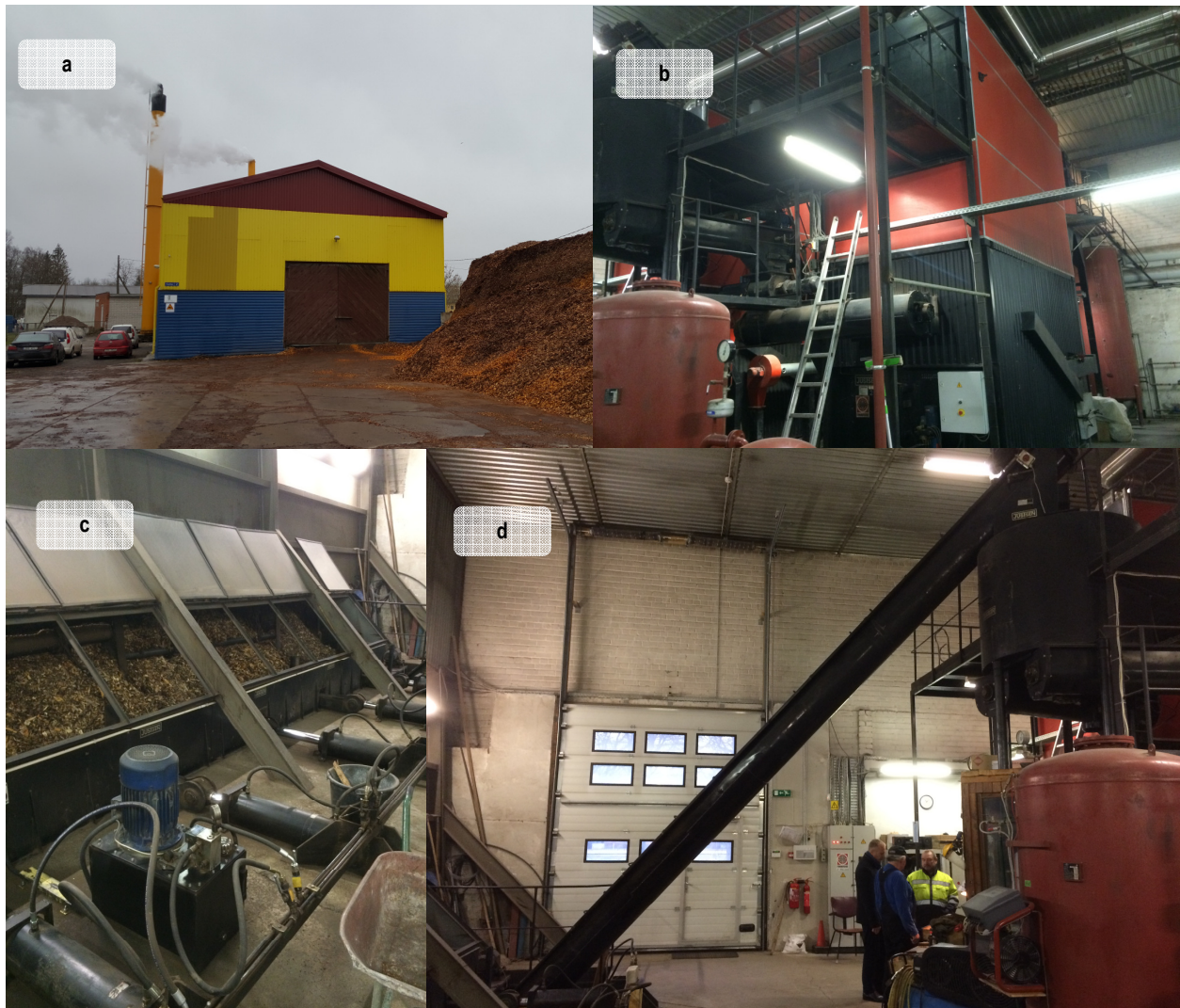
Joonis 3.1.1 – a). Kehra katlamaja hoone koos kütuselaoga, b). Katel Danstoker, c). Ringluspump koos etteandesüsteemiga, d). Laokraap
